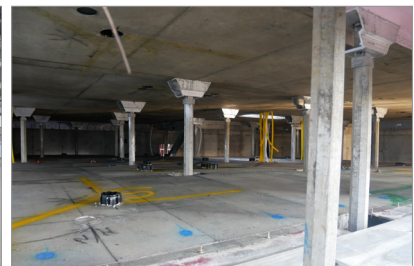
슬래브 드롭 후
