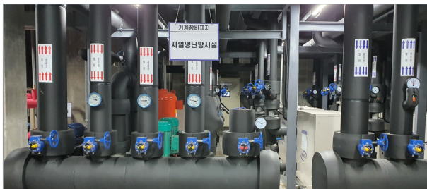
[딥코일300] 기계실 및 자동제어 설치_지열냉난방
